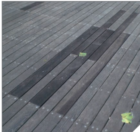
Ausgetauschte Dielen sind über einen längeren Zeitraum deutlich erkennbar.
