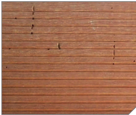
Kleine Löcher durch Insektenfragsgänge sind bei einigen Tropenhölzern normal und nicht vermeidbar.
