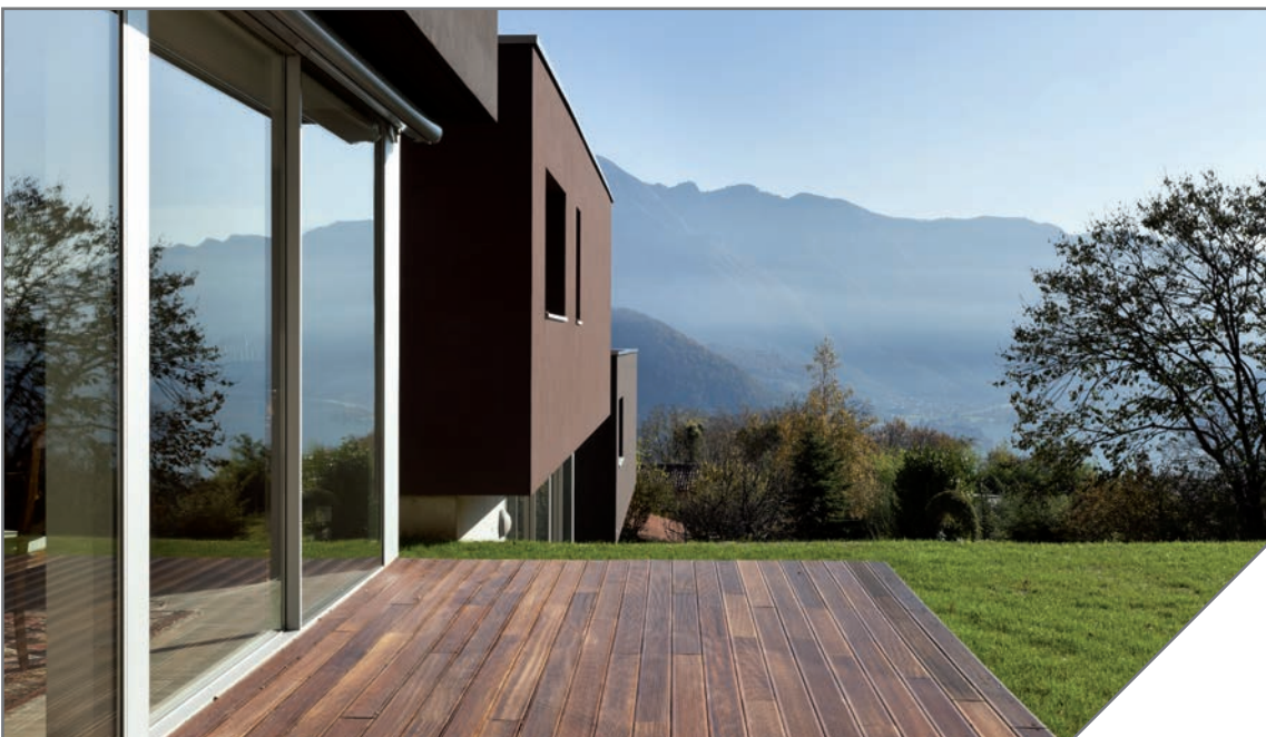
Regelmäßige Behandlungen der Terrassenoberfläche führt zu einem gepflegten Terrassenbild.
