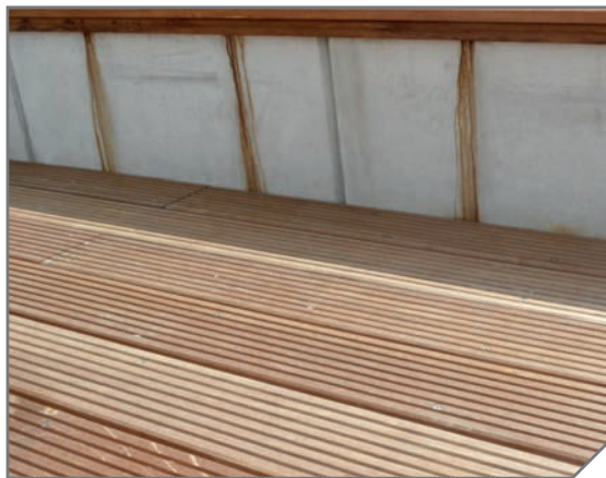
Farbunterschiede und Wasserflecken können sich bei luftgetrockneter Ware abzeichnen.
