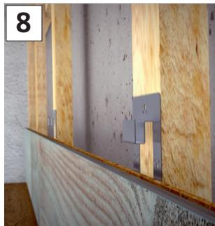
Vor der Montage der zweiten Reihe werden die 3D-Profilkrallen auf die Paneele der ersten Reihe gesteckt und auf den Konterlattens befestigt. Auf jeder Konterlatte muss dabei eine Profilkralle montiert werden. Die Profilkrallen sind so anzuordnen, dass die geöffnete Seite des Krallengrundkörpers nach unten weisen [8,9].
